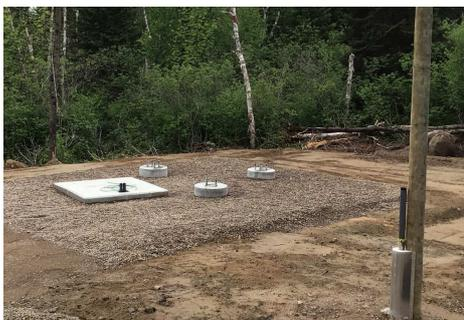
Sur la photo de gauche, on peut voir que les fondations de la tour située près du chemin Baie-William Ouest sont terminées; suivra la construction de la partie métallique, l'installation des antennes et le raccordement à la fibre optique, laquelle est déjà sur place.
