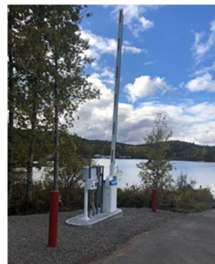
Barrière à la rampe de mise à l'eau au parc Grégoire-Descarreaux
